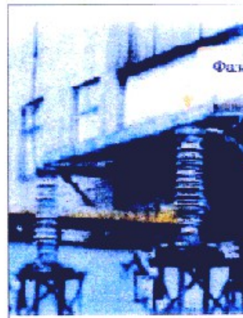
Нормальное распределение температуры по высоте элемента ОПН-110 кВ фазы "К" и увлажнение кварцевого песка в элементе фазы "З" (термопрофили 2 и 1)
